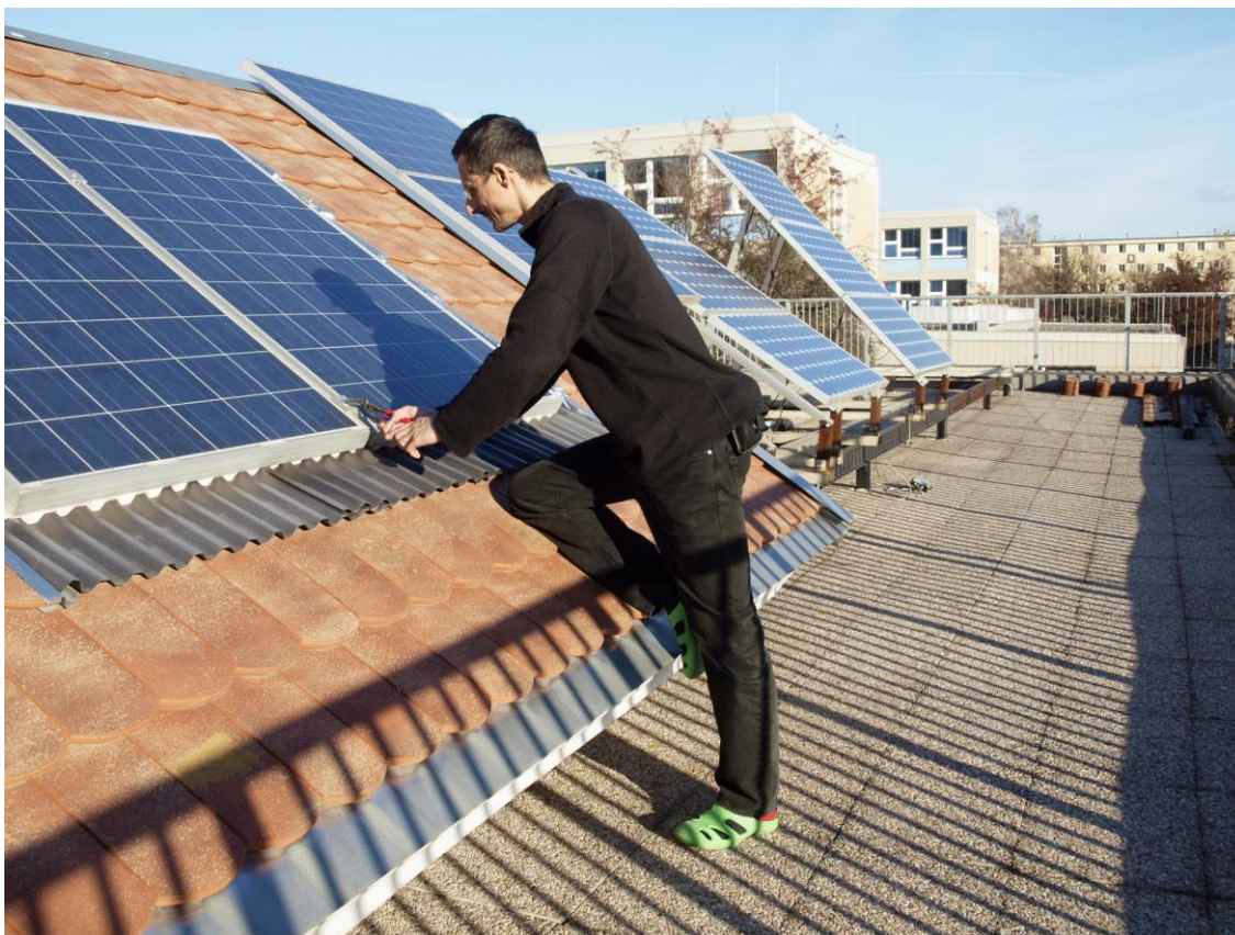
2015 Montáž fotovoltaického systému
