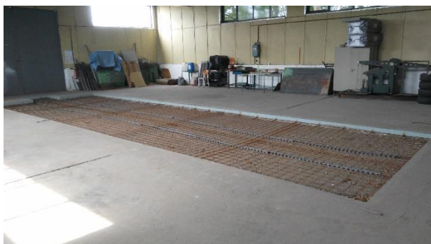
Oprava podlahy po válcové zkušebně
