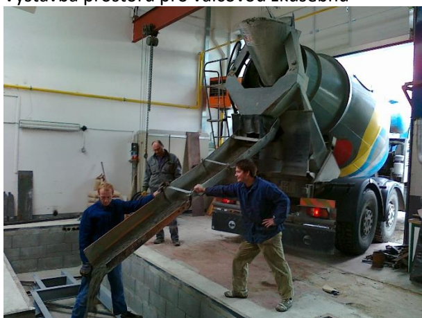
Betonování rámu (dr. Miler, dr. Hromádko)
