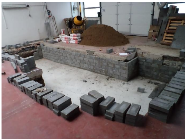
Výstavba prostoru pro válcovou zkušebnu
