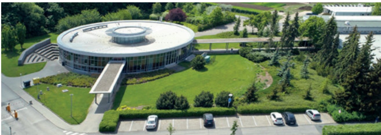
Rekonstrukce kruhové haly – těsně po dokončení. Reconstruction of the circular hall – just after completion.
